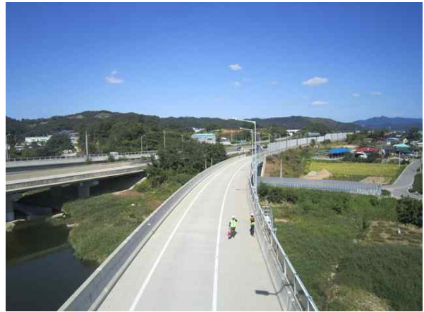
교량 상부 전경
