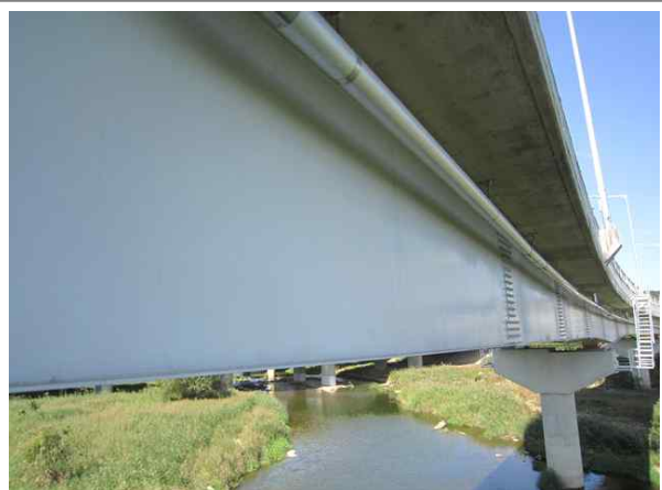
교량 거더 전경
