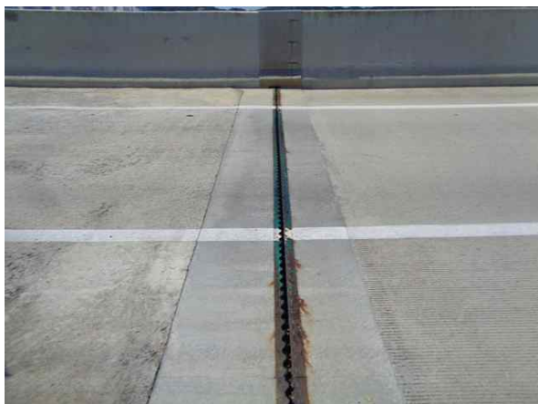
교량 상부 전경
