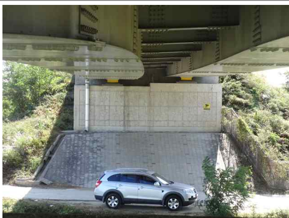
교량 하부 전경
