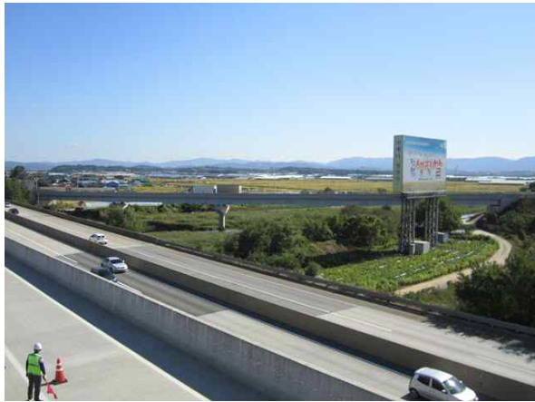
교량 측면 전경
