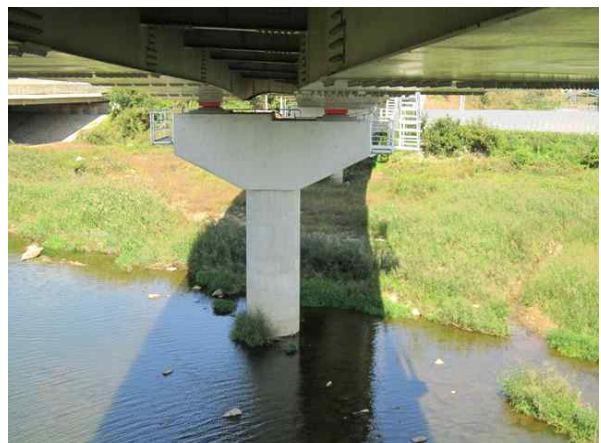
교량 하부 전경
