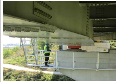
▲ 교량받침 점검로 근접조사
